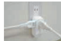
コンセント差し込み口3個
